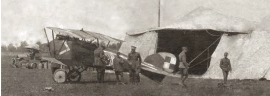
Albatros 7. Eskadry na lotnisku w Połonnem. W tle przenośny płócienny hangar, jakich używała eskadra na polowych lądowiskach. Mieścił się w nim jeden samolot.
